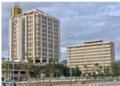
Antiguo edificio de Correos
